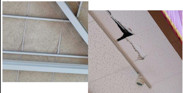
木毛セメント板目地部材のずれ2カ所
