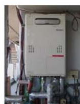
温水床暖房用 高効率給湯機
