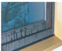
アルミサッシと単板ガラスを使用
