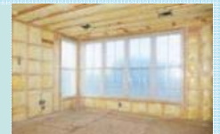
天井・壁・床等の断熱改修
