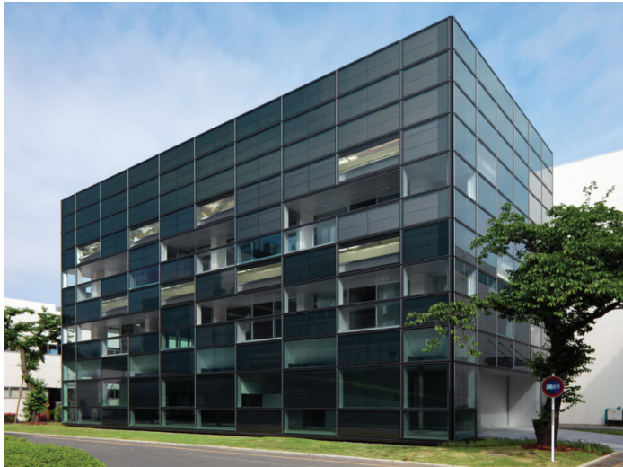
大成建設(株)技術センター ZEB実証棟
