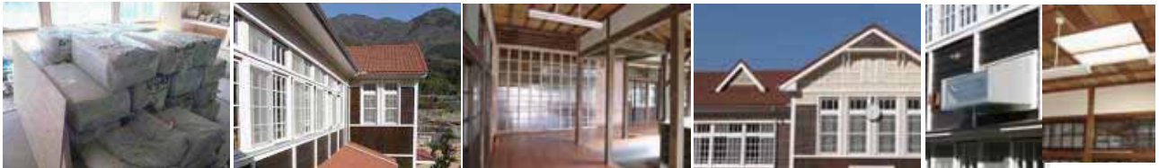
古紙再生断熱材 木製気密サッシ+複層ガラス 階段室の防寒間仕切り 復活した小屋裏換気口 自然採光用光ダクト
