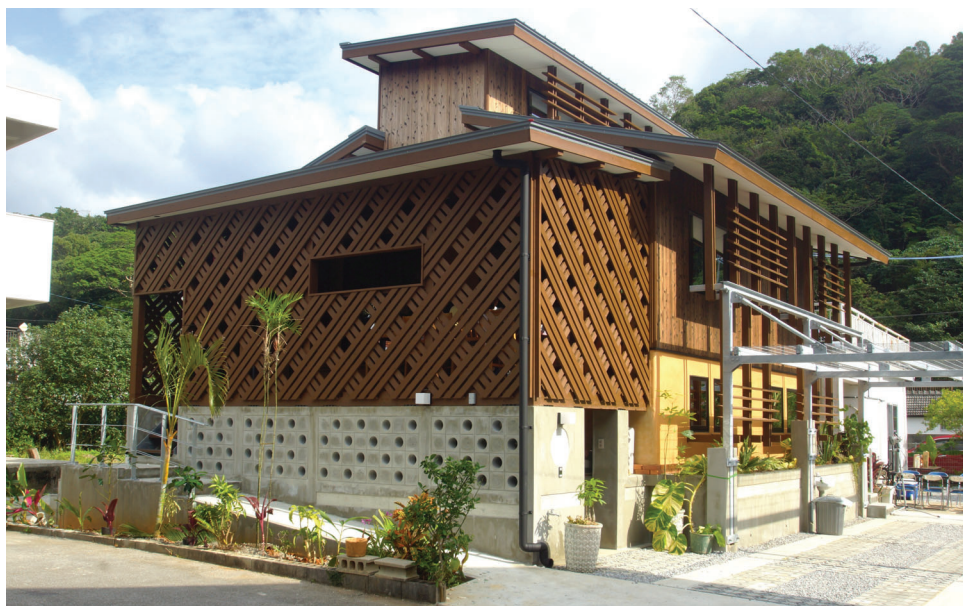
南西側から見たファサード
