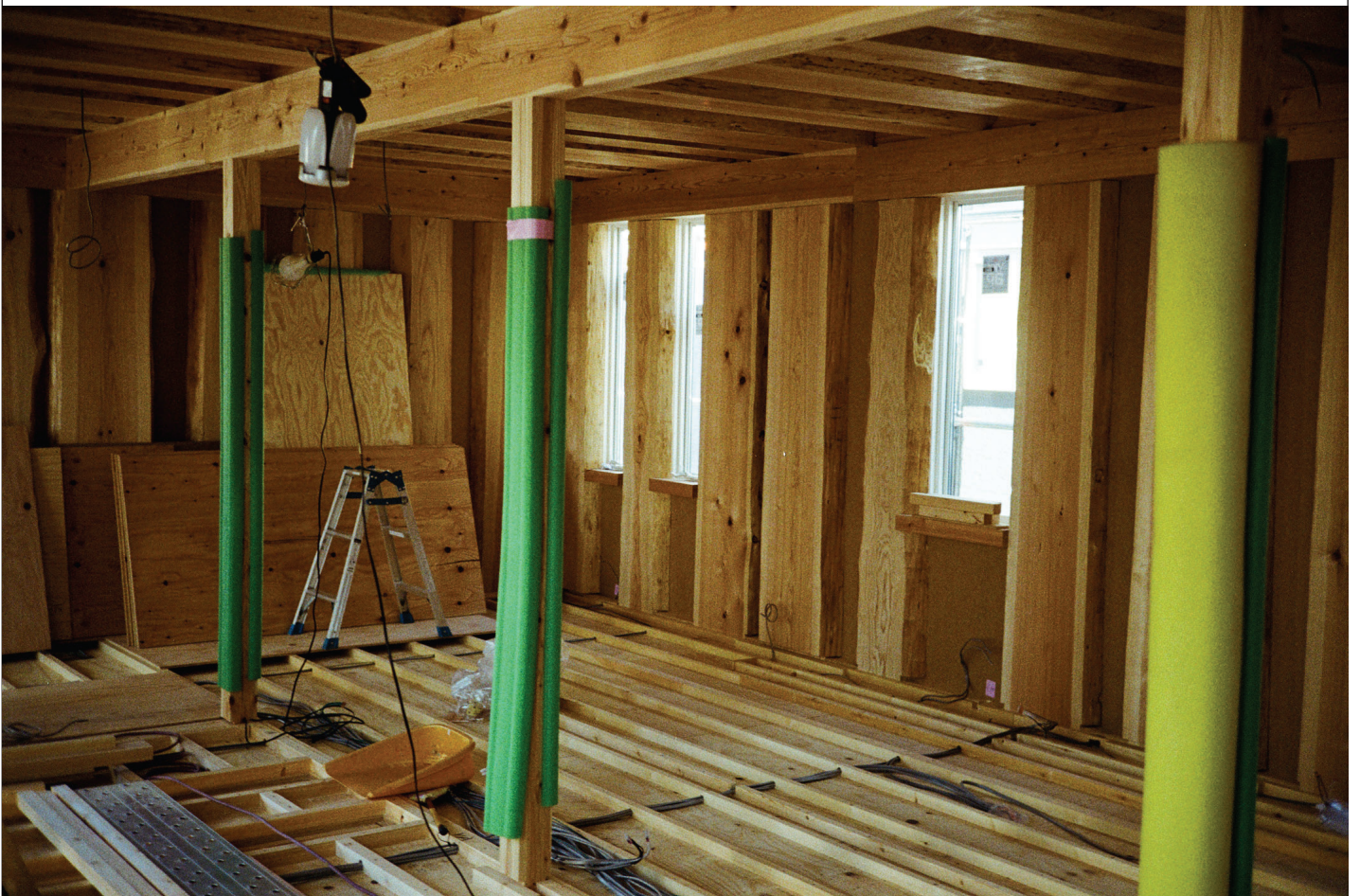
大工工事 5 JAN 2024
