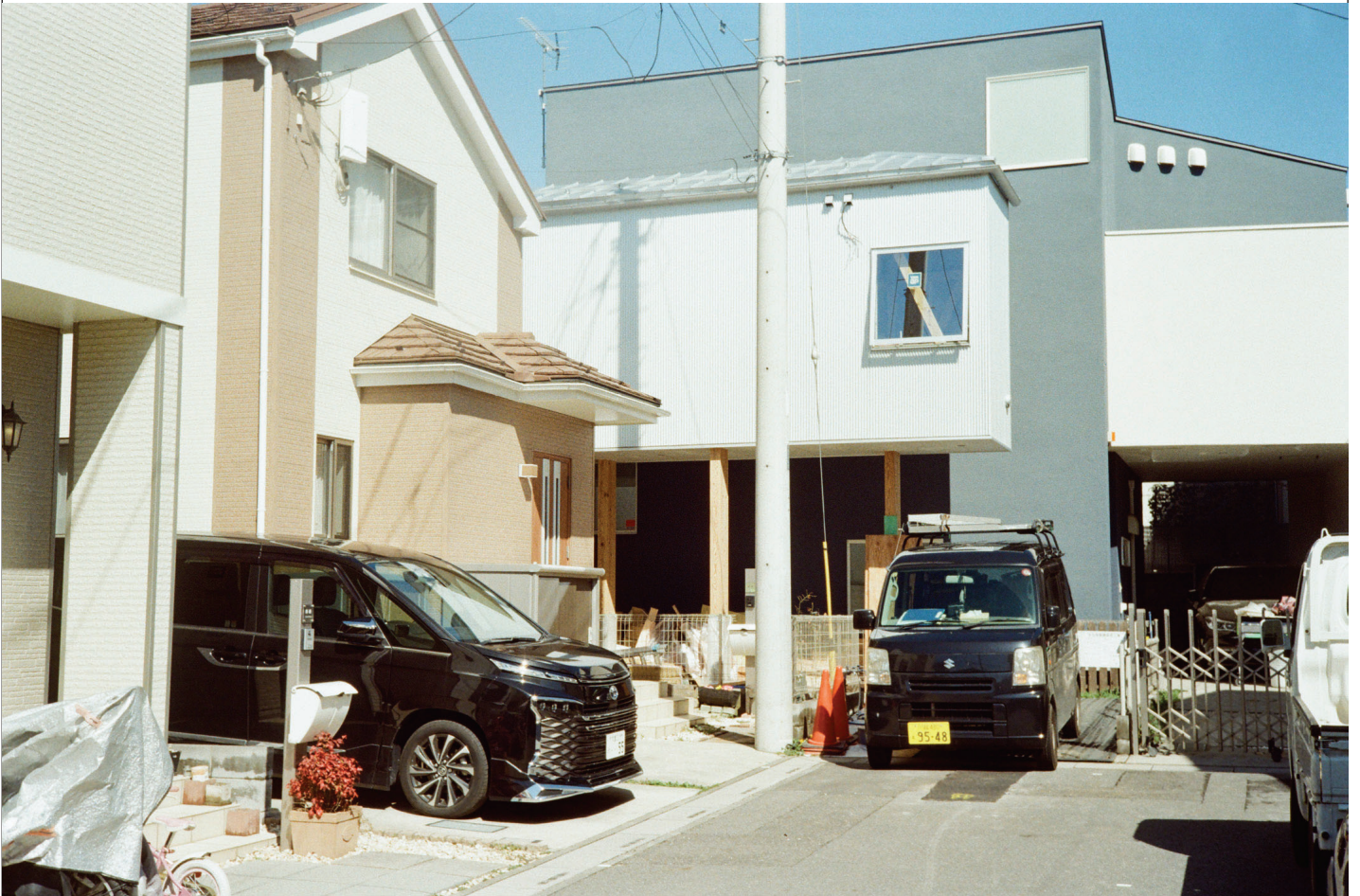
仕上工事 1 MAR 2024
