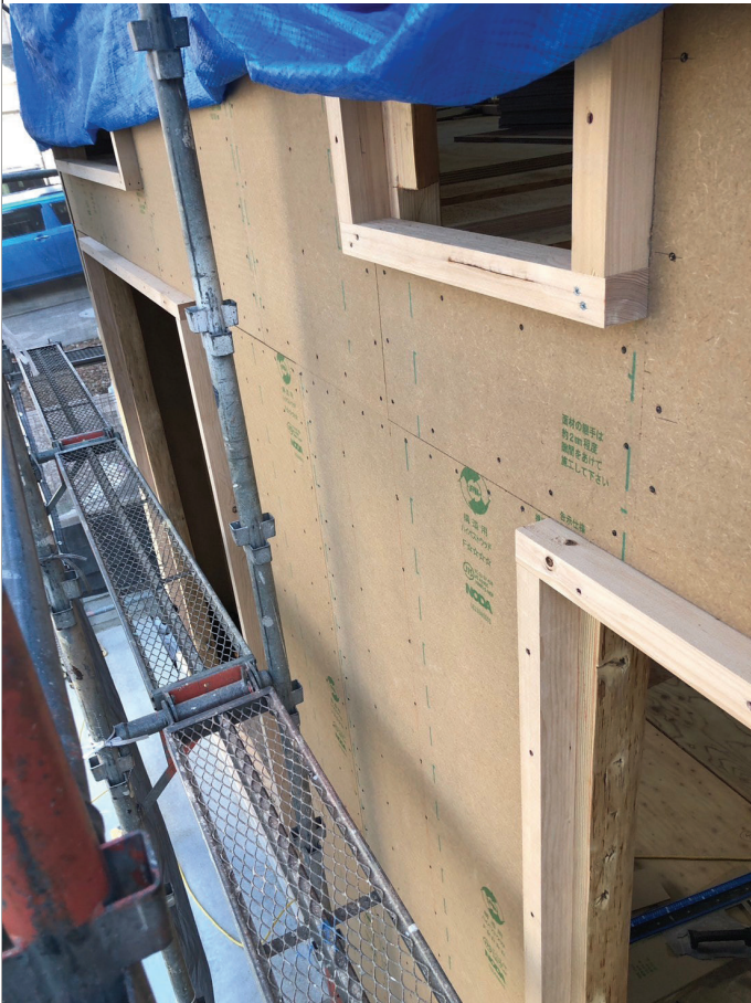
外壁断熱工事
