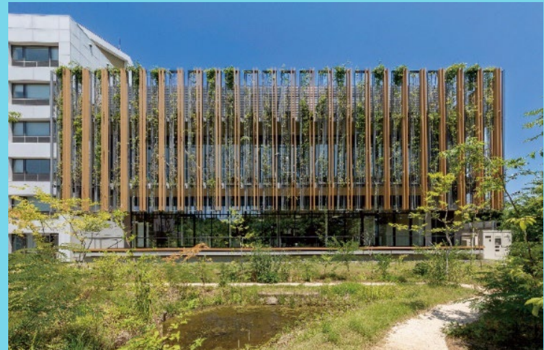
第1回 国土交通大臣賞(中・小規模建築部門) 「戸田建設筑波技術研究所 グリーンオフィス棟」
