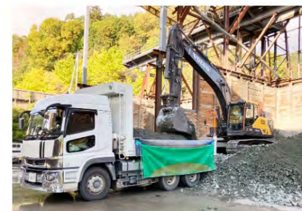
電動大型バックホウの作業状況
