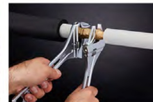
写真-2 アルミ冷媒配管用機械式継手の施工
